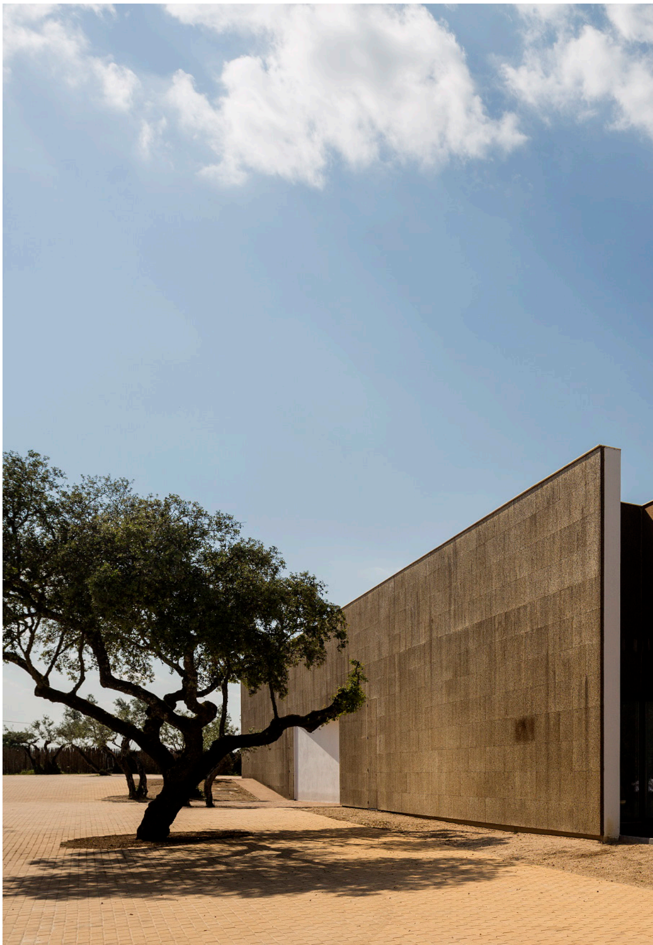
ECORKHOTEL, EM ÉVORA, COM A FACHADA REVESTIDA A AGLOMERADO DE CORTIÇA EXPANDIDA, DA AMORIM ISOLAMENTOS
