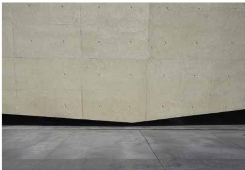
Kreuzfahrtterminal Lissabon unter Verwendung einer Art von weißem Leichtbeton mit Korkgranulat.
