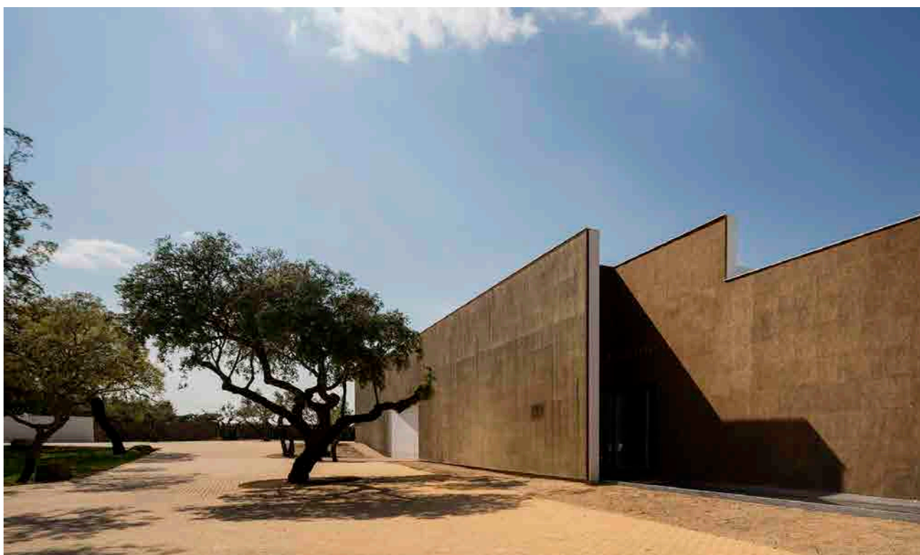
FACHADA REVESTIDA A AGLOMERADO DE CORTIÇA EXPANDIDA
