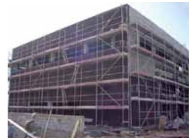
Fotografia 1 - Fachada preparada / isolada com cortiça para receber acabamento ETICS
