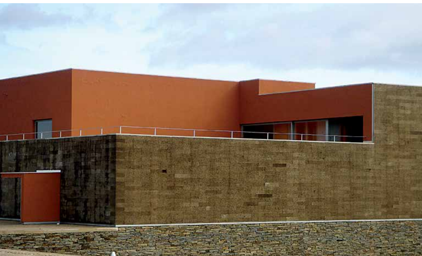
Quinta do Portal (MD Fachada), de Álvaro Siza Vieira | Prémio de Arquitetura do Douro
