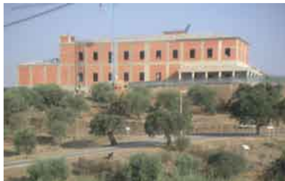
Novo secadeiro da Casa do Porco Preto em fase final de construção
